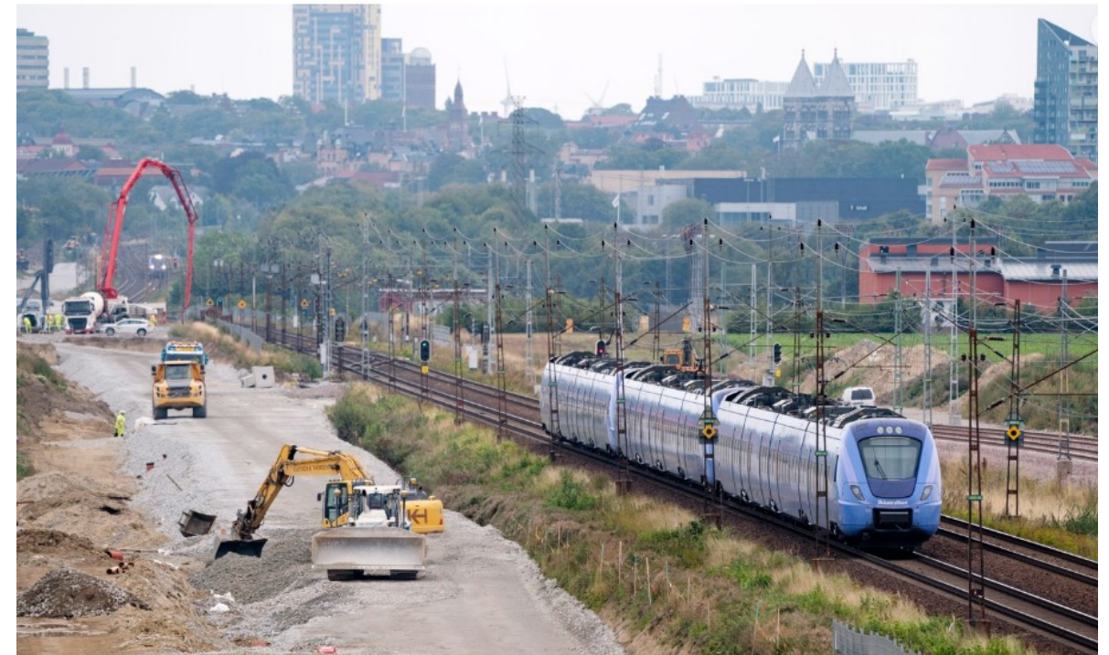
Arbete på sträckan Malmö–Lund år 2020 för bygge av fyra spår i stället för dubbelspår. Foto: Johan Nilsson/TT
