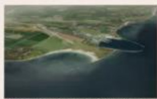
Så här väntas havnen och tunneltvättning i Puttgarden se ut när projektet är färdigt. |
