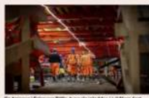
Gjutningen i Fehmarns Bält-tunneln inleds i juli följande år.
