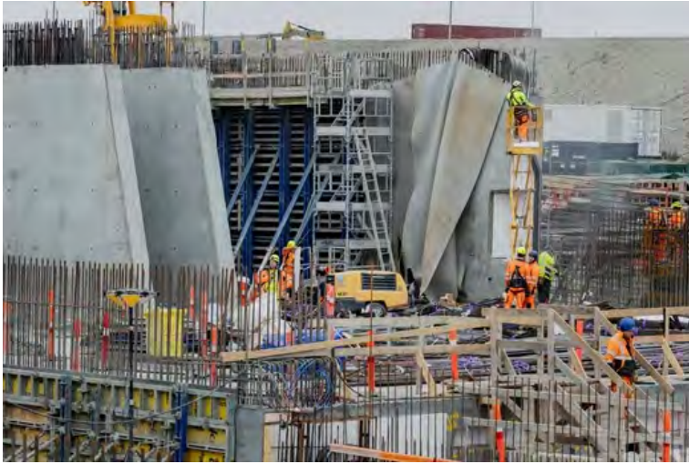
Bilden visar en del av de cirka 300 meter tunnel som stöps på land. Bottenplattan är stöpt och väggarna är på väg. Foto: Anders Hansson
