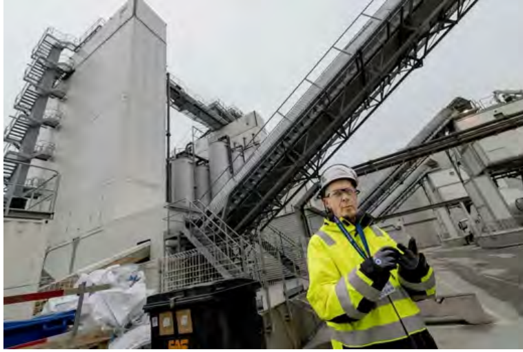
Betongansvarige Ulf Jönsson vid ett betongverk i fabriksområdet i Rödbyhamn.
